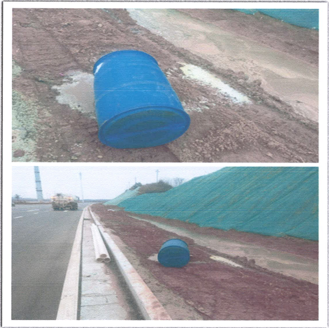
图为三氯氧磷化学品泄露情况
